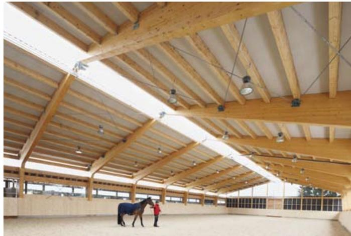
◀ Stützenfrei überspannen die 21 m langen Brett-schichtholz-binder die Reithalle. Von unten sichtbar: die Dämmelemente zwischen den Pfetten
