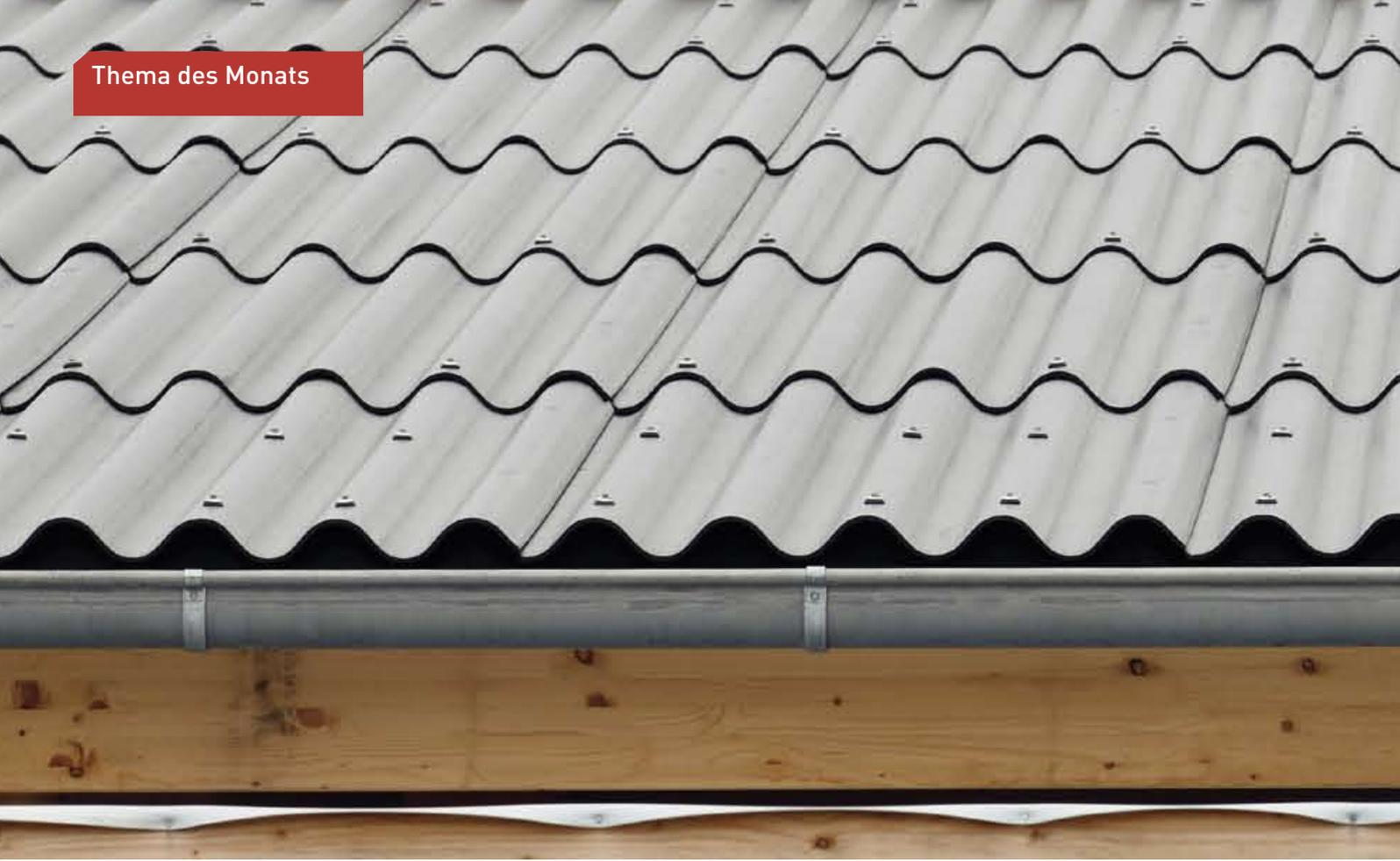
▲ Mit fünf Wellen pro Platte, einer Nutbreite von 873 mm und einer Länge von bis zu 3100 mm bietet Profil 5 eine preiswerte Lösung für große Dächer
